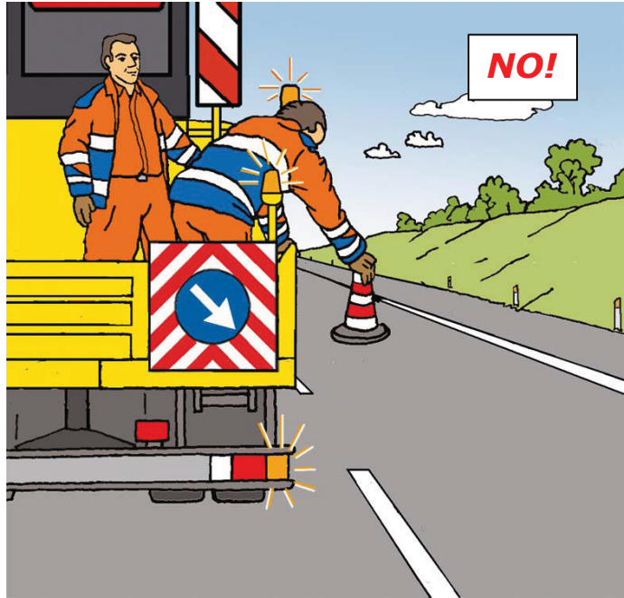
Figura 60 – Posizionamento dei coni o defleco: comportamento scorretto
